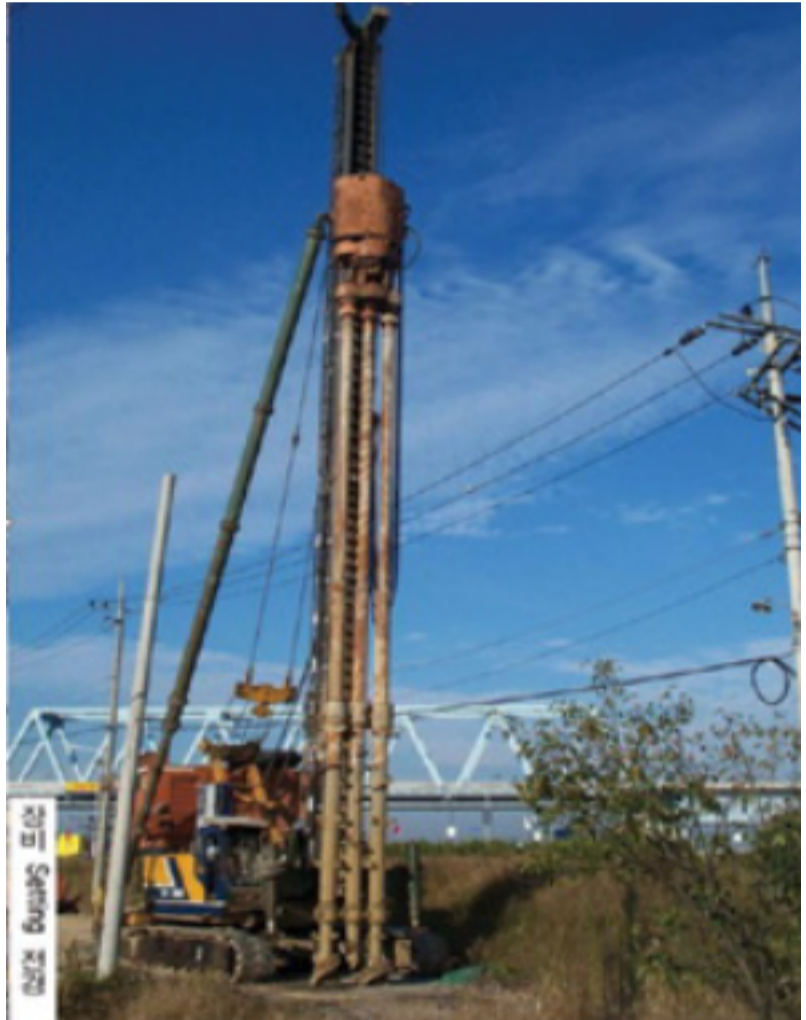
제방보강공사 장면 / Pile Driver
