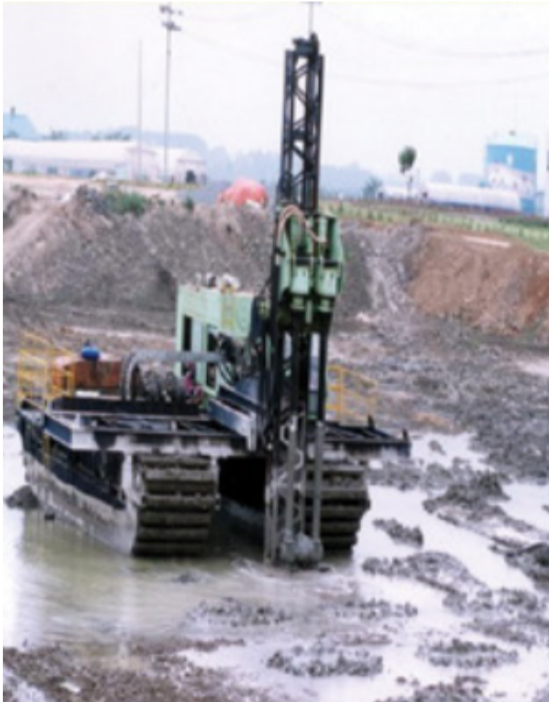
연약지반 보강공사 장면 / LVT
